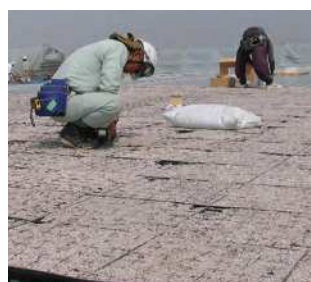
③ 土壌コンテナを受座チャンネルに固定
