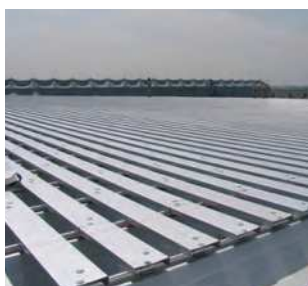
② 受座チャンネル敷設
