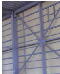
内装仕上がり状況
