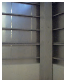
内装仕上がり状況
