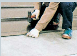
専用スライド吊子を下地に取り付け
