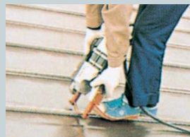
吊子をスポット溶接で取り付けで仮止め
