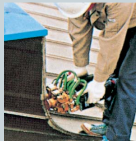
役物部分を手持式仕舞用シーム溶接機
