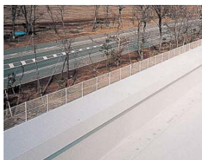
⑤ハイタフシート立上り部の施工
