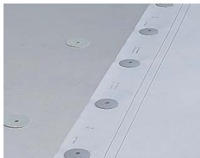
③ハイタフシートの敷込みと緊定
