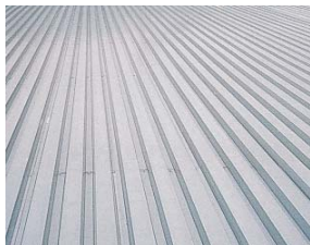
①デッキプレートの敷込みと緊定
