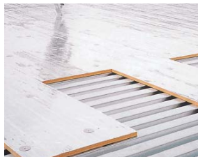
②断熱材の敷込みと緊定
